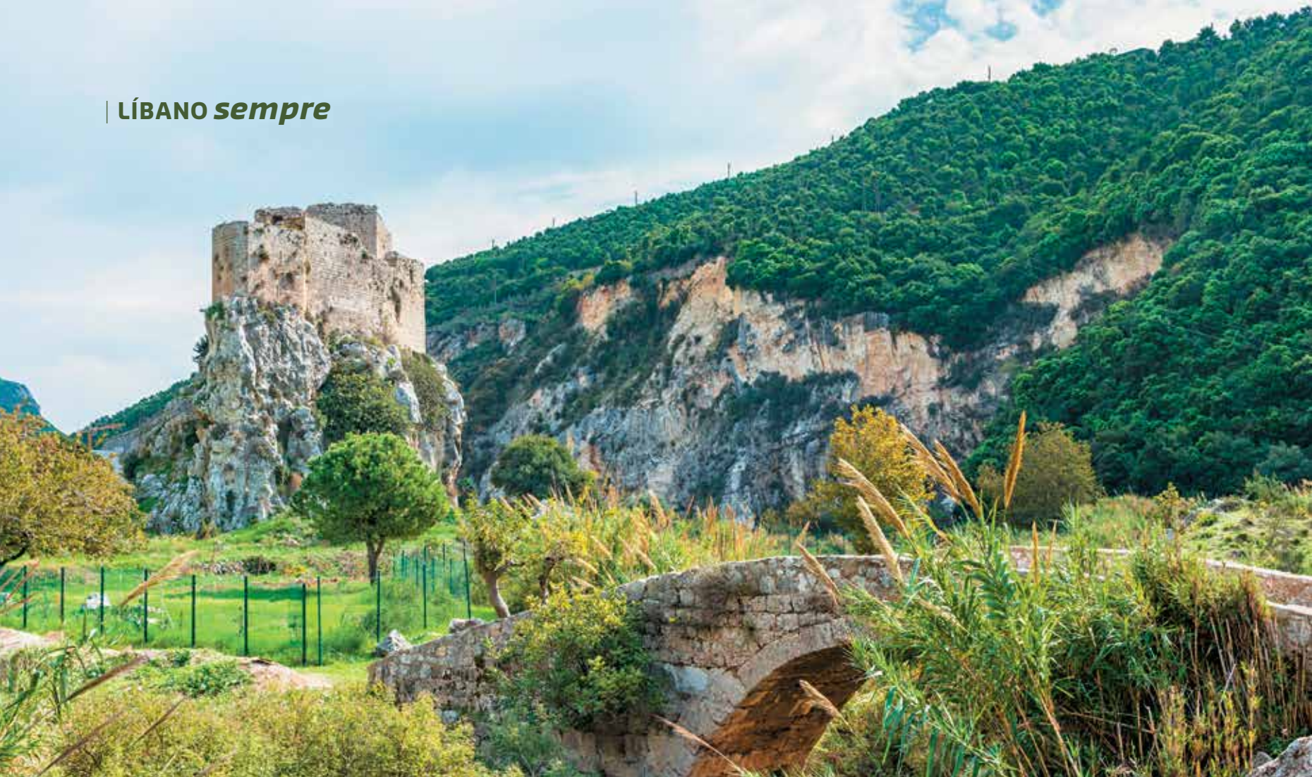
Acima, vista externa do Forte de Mseilha
